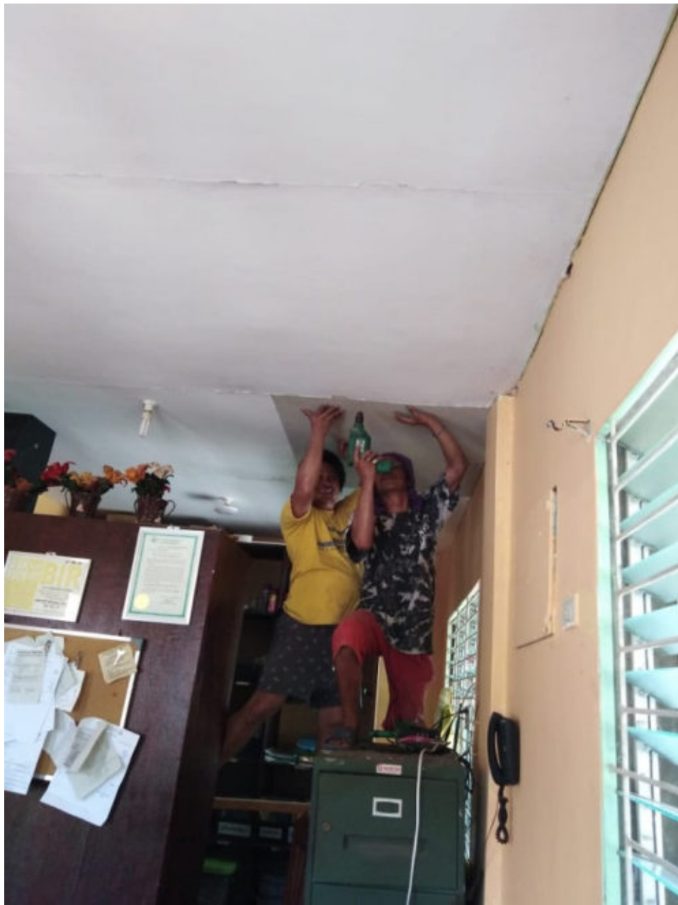
Fixieren der Decke im Büro
